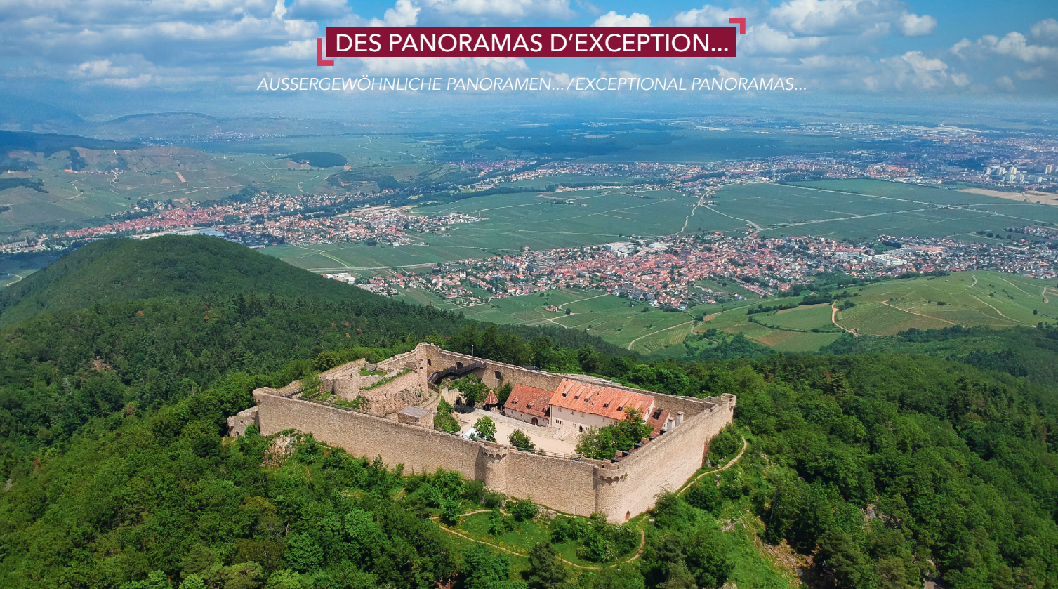
Château du Hohlandsbourg
